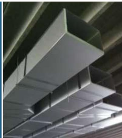
Conductos fabricados con espuma rígida de poliisocianurato (PIR) o Poliuretano (PUR), revestida en ambas caras con láminas de aluminio.
